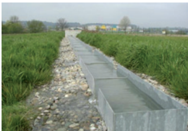
Einlasskanal eines Retentionsfilterbeckens
